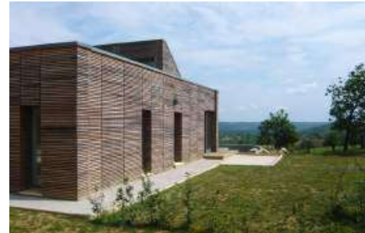
Figure 40 : Maisons individuelle bioclimatique, source : CAUE 31.
