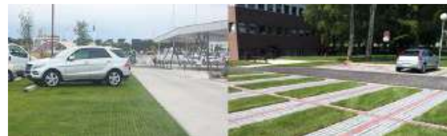
Figure 72 : Exemple de parkings végétalisés (sources : Place du pro ; O2D Environnement)
