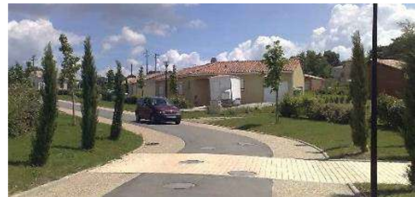
Figure 16 : Exemple de voirie mixte, source : CAUE 31.
