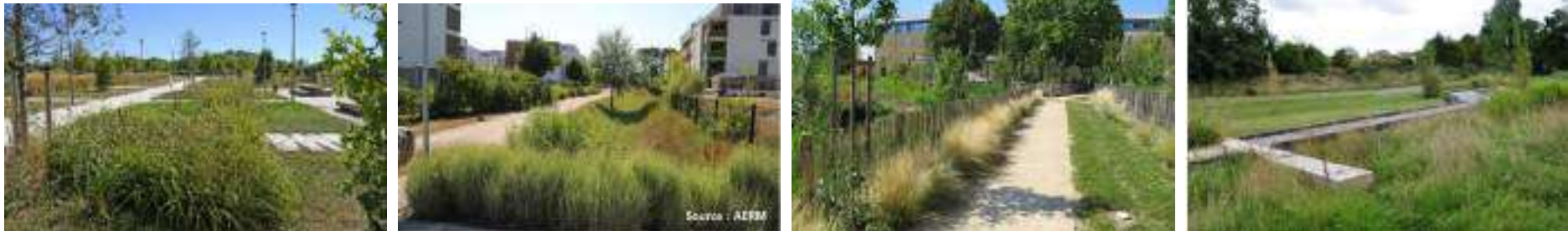
Figure 21 : Exemples de dispositifs de gestion des eaux pluviales paysagers, sources : CAUE 31.
