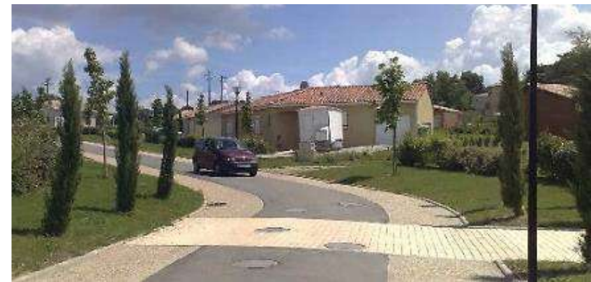
Figure 34 : Exemple de voirie mixte, source : CAUE 31.
