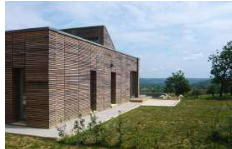
Figure 22 : Maisons individuelle bioclimatique, source : CAUE 31.
