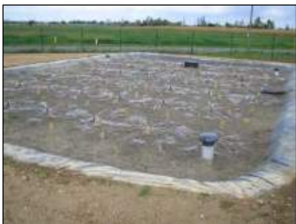
Filtre récemment construit : les roseaux n'ont pas encore poussé
